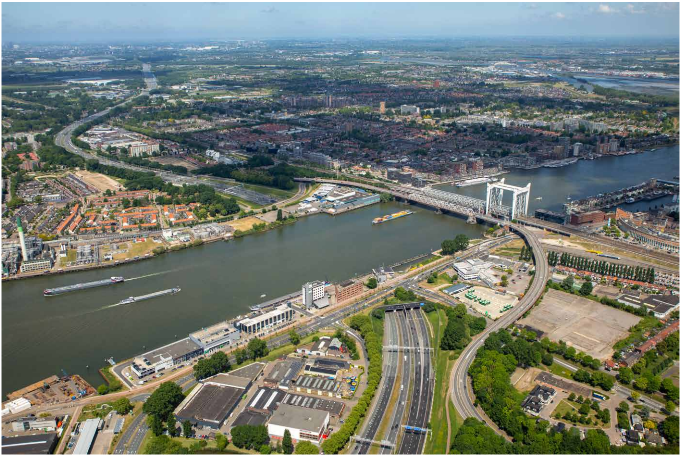
Drechtunnel (Foto: Rijkswaterstaat)
