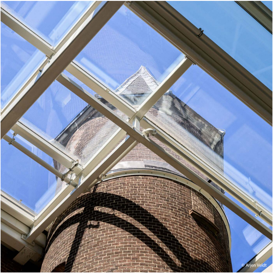
Aansluiting nieuwe overkapping op bestaand torentje
