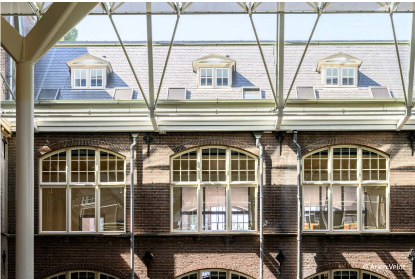
Aansluiting nieuwe overkapping op bestaand gebouw
